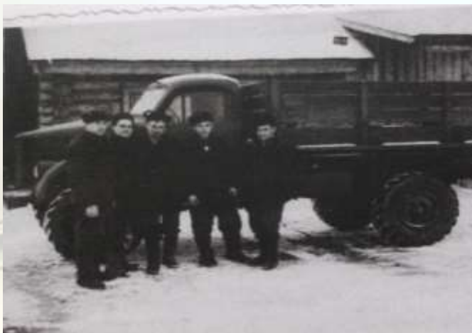
Строители здания Октябрьского клуба и библиотеки
